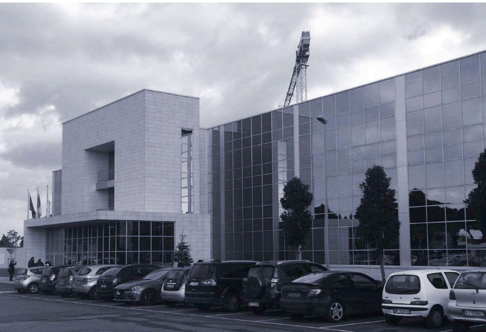
Collaudo Tecnico Amministrativo Sito ENAV ACC Roma
