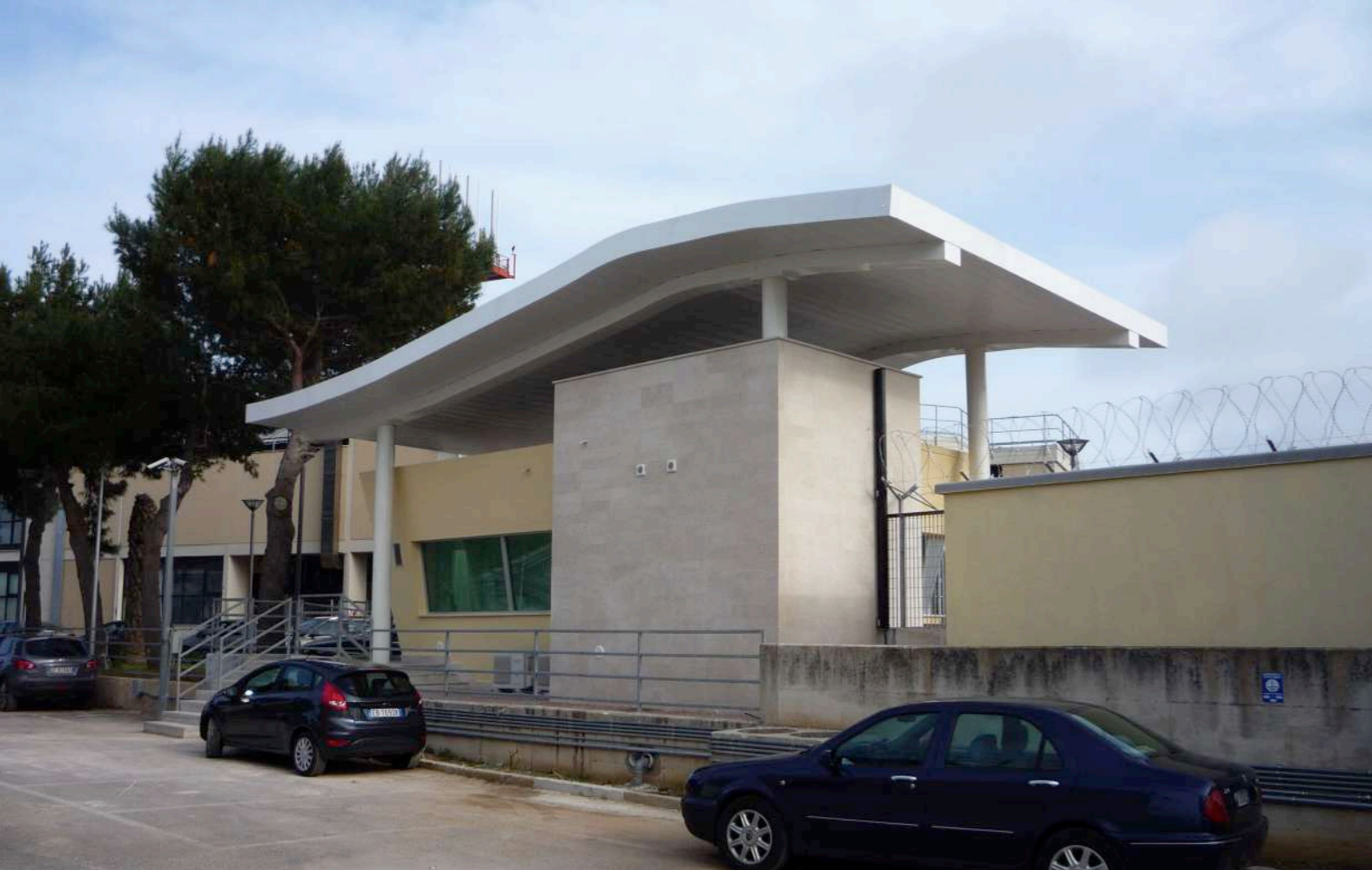
Nuovo Edificio Controllo Accessi dell'edificio ACC presso l'aeroporto di Brindisi
