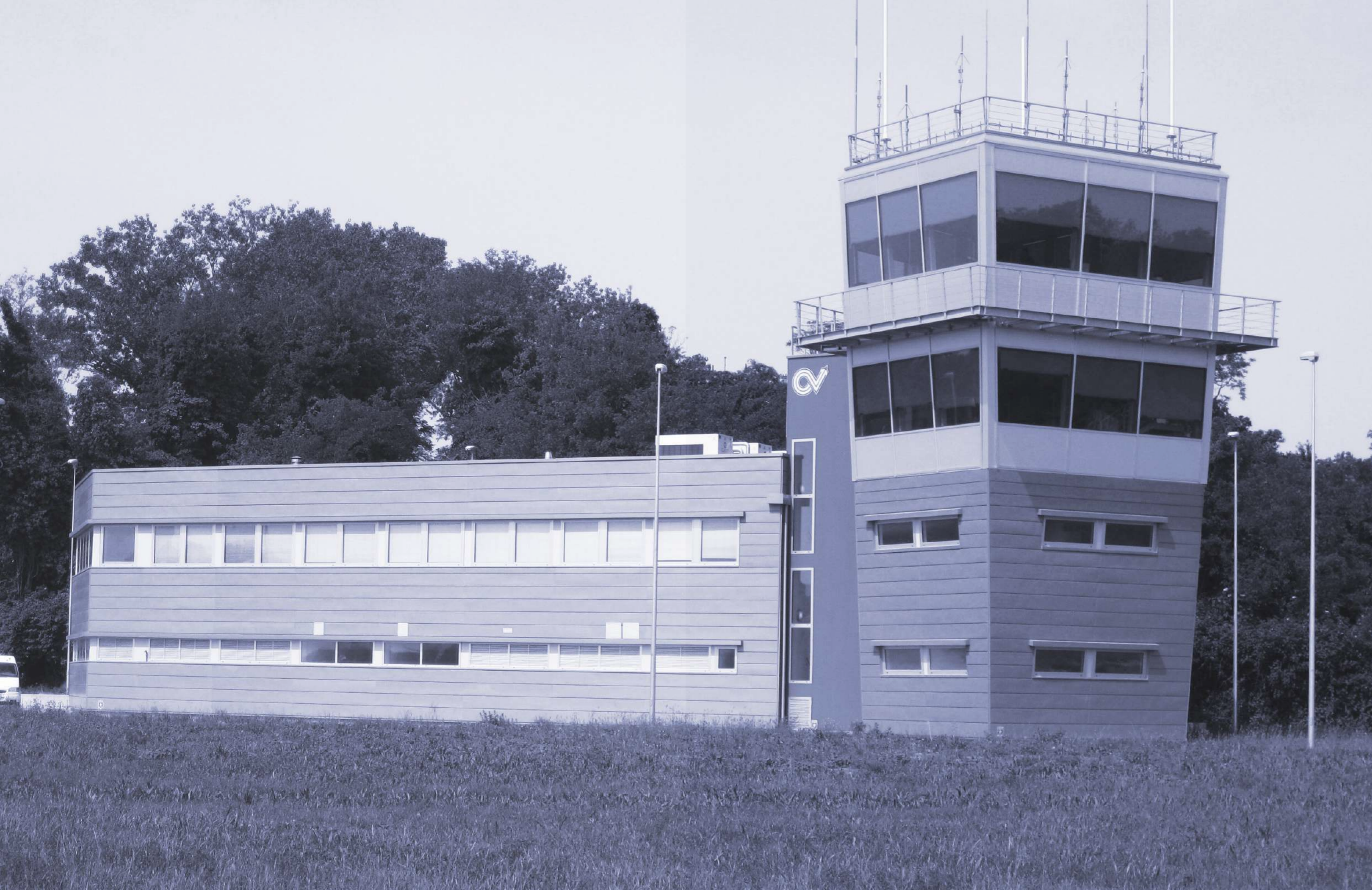
Collaudo Tecnico Amministrativo in corso d'opera per i lavori di realizzazione del Nuovo Blocco Tecnico e della Nuova Torre di Controllo dell'Aeroporto di Venezia Lido.
