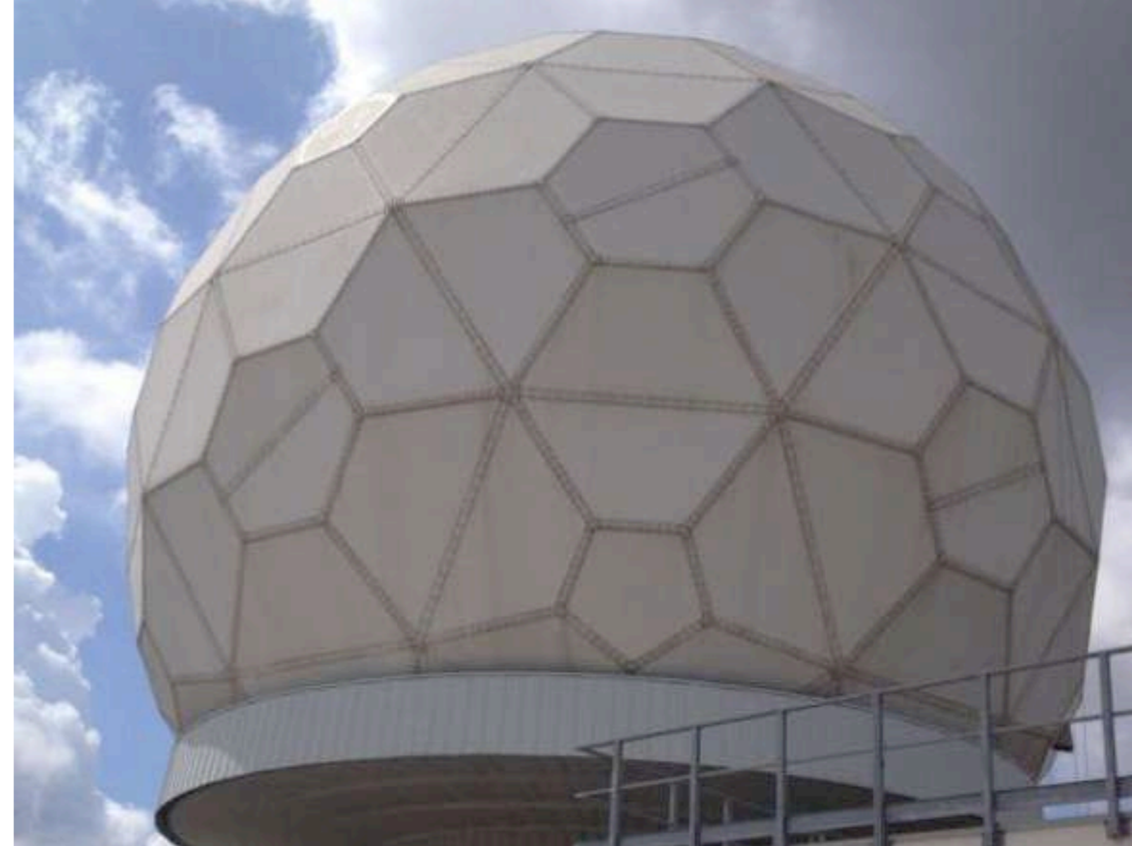
Sito Radar di Maccarese - Opere di ricondizionamento civili ed impiantistiche - Progettazione preliminare e definitiva, Direzione Lavori e Coordinamento della Sicurezza
