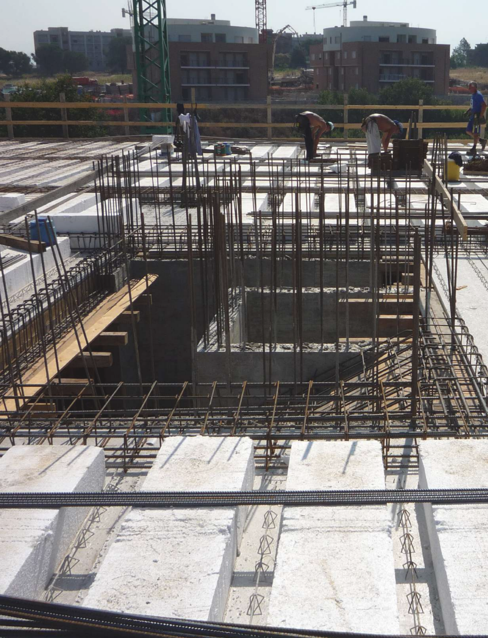
Direzione Lavori di realizzazione di n.46 alloggi - Piano di Zona C2Ter Lunghezza
